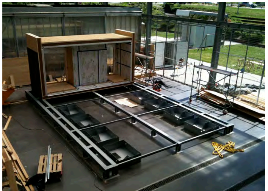
Photo 2. Foundation system - View under construction with SKIN at GAIA Système de fondation. Vue en cours de construction aux GAIA avec SKIN en place
