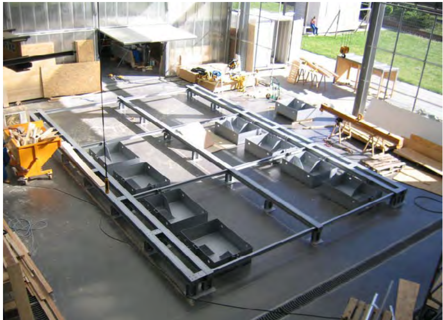
Photo 1. Foundation system - View under construction at GAIA Système de fondation. Vue en cours de construction aux GAIA
