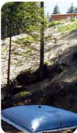
Réserve de 20 m 3 pour site isolé
