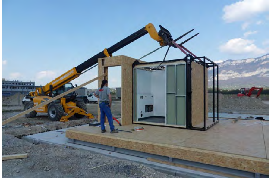
Photos 9. SKIN - Views of Armadillo Box® INES Variation panels under assembly at INES SKIN - Enveloppe isolante. Vue des panneaux en cours d'assemblage à l'INES
