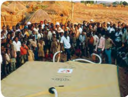
Stockage d'eau potable 20m 3
