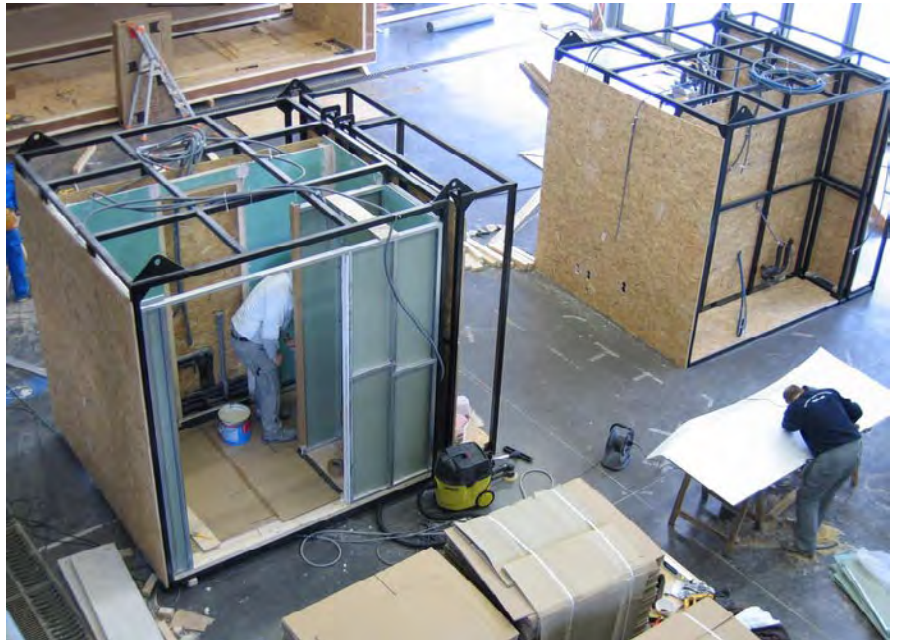
Photo 4. CORE - Views under construction at GAIA and INES Cœur technique. Vue en cours de construction aux GAIA et à l'INES
