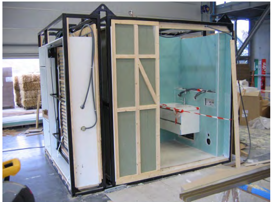
Photos 3. CORE - Views under construction with built-in kitchen and bathroom CORE. Vue en cours de construction avec cuisine et salle-de-bain intégrées
