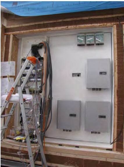
Photos 10. SKIN - Views of equipments assembly at GAIA SKIN - Enveloppe isolante. Mise en place des équipements techniques aux GAIA
