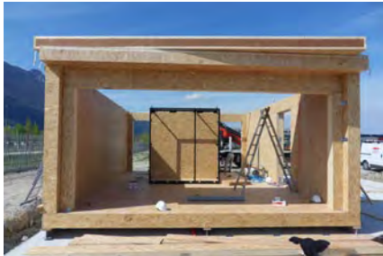
Photos 9. SKIN - Views of Armadillo Box® INES Variation panels under assembly at INES SKIN - Enveloppe isolante. Vue des panneaux en cours d'assemblage à l'INES
