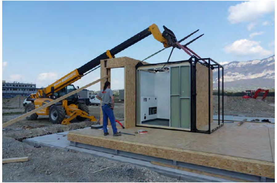
Photos 5. CORE - Views under setting in place at GAIA and INES Cœur technique. Vue en cours de mise en place aux GAIA et à l'INES
