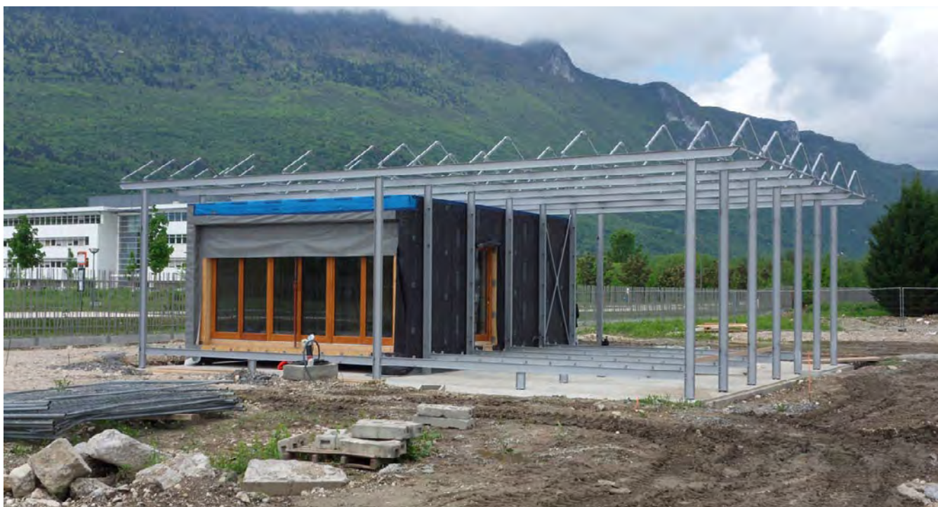
Photos 14. SHELL - Views of INES Variation steel portal frame assembly in Bourget-du-Lac SHELL - Vues du montage des portiques acier de la Variation INES au Bourget-du-Lac
