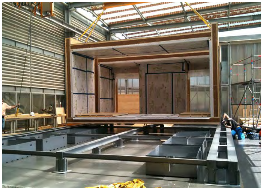
Photos 8. SKIN - Views of ring sections under assembly at GAIA SKIN - Enveloppe isolante. Vue des anneaux en cours d'assemblage aux GAIA
