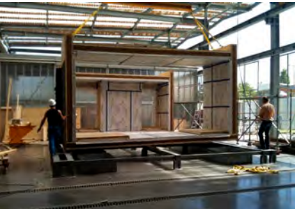
Photos 8. SKIN - Views of ring sections under assembly at GAIA SKIN - Enveloppe isolante. Vue des anneaux en cours d'assemblage aux GAIA
