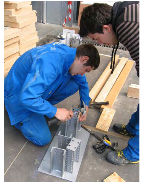
Photo 2. Foundation system - View under construction with SKIN at GAIA Système de fondation. Vue en cours de construction aux GAIA avec SKIN en place
