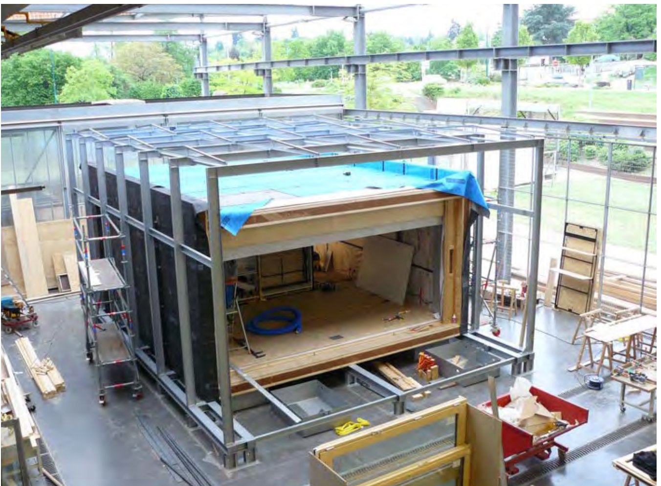
Photos 15. SHELL - Views of steel portal frame assembly at GAIA SHELL - Vues du montage des portiques acier aux GAIA
