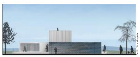
Bild 7: Solarwand mit verschiedenfarbigen Solarzellen für eine individuelle Fassandengestaltung
