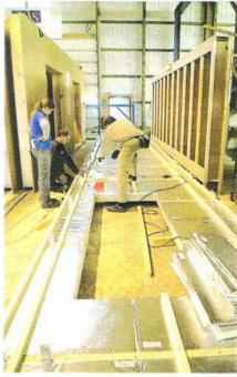
Alle Bauteile bestehen aus einem Verbund aus tragenden Profilhölzern, isolierten Holzprofilen, integrierter Wärmedämmung (teilweise Vakuum) und OSB-Schalen, die zugleich auch als Flächenaussteifung wirken.
